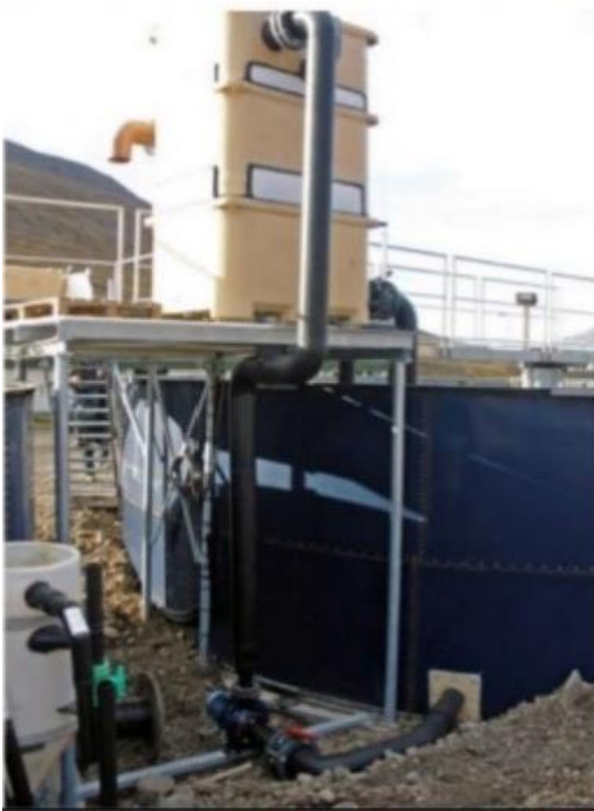
MYND 2.12 Loftari við eldistank ásamt skýringu á grunnvirkni loftara.
