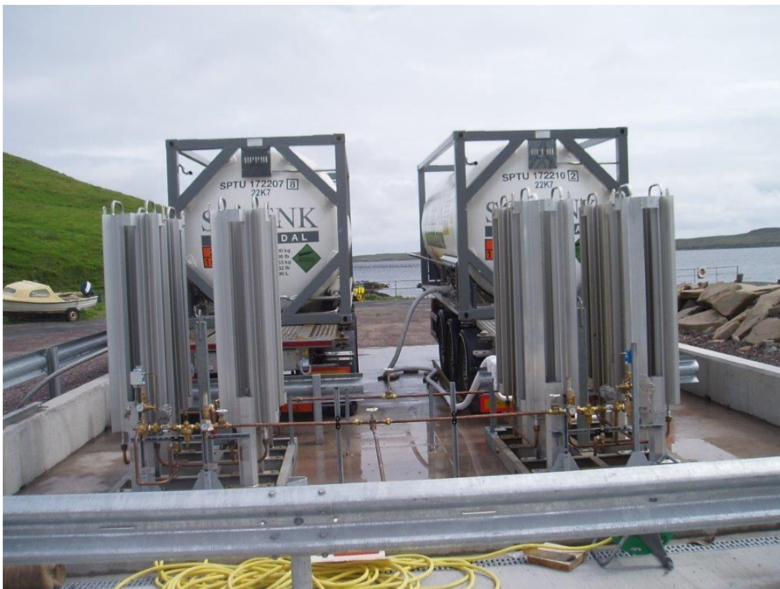
MYND 2.11 Súrefnistankar staðsettir í staði þar sem þeir eru tengdir við eimara. Mynd: EFLA
